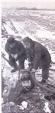
Pose d'un câble souterrain par une équipe des LGD.
