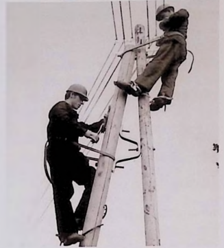
Agents des Lignes avec équipement réglementaire - casque, gants, ceinture et chaussures - lieu non précisé, sd. Copyright, archives CGT-FAPT
